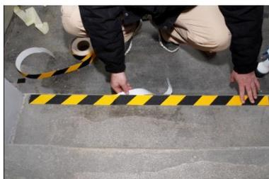
5. Gewünschte Länge des Bandes abschneiden, Schutzliner teilweise abziehen, Band ausrichten (bei Stufen im Abstand von ca. 15 mm von der Vorderkante, um eine Beschädigung des Randes zu vermeiden), restlichen Liner nach und nach abziehen und Band an-drücken.
